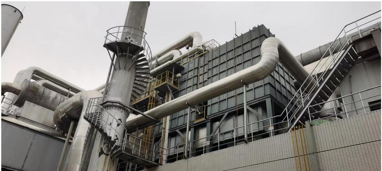
图3.8-5 现有软包生产线RTO装置照片
