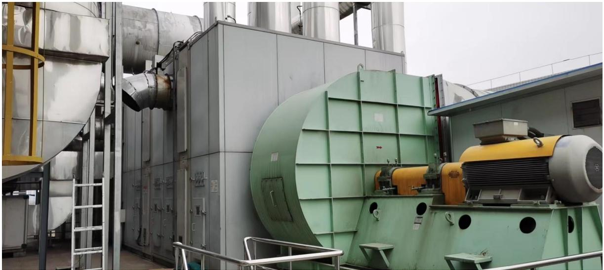
图3.8-4 现有软包生产线沸石转轮装置照片
